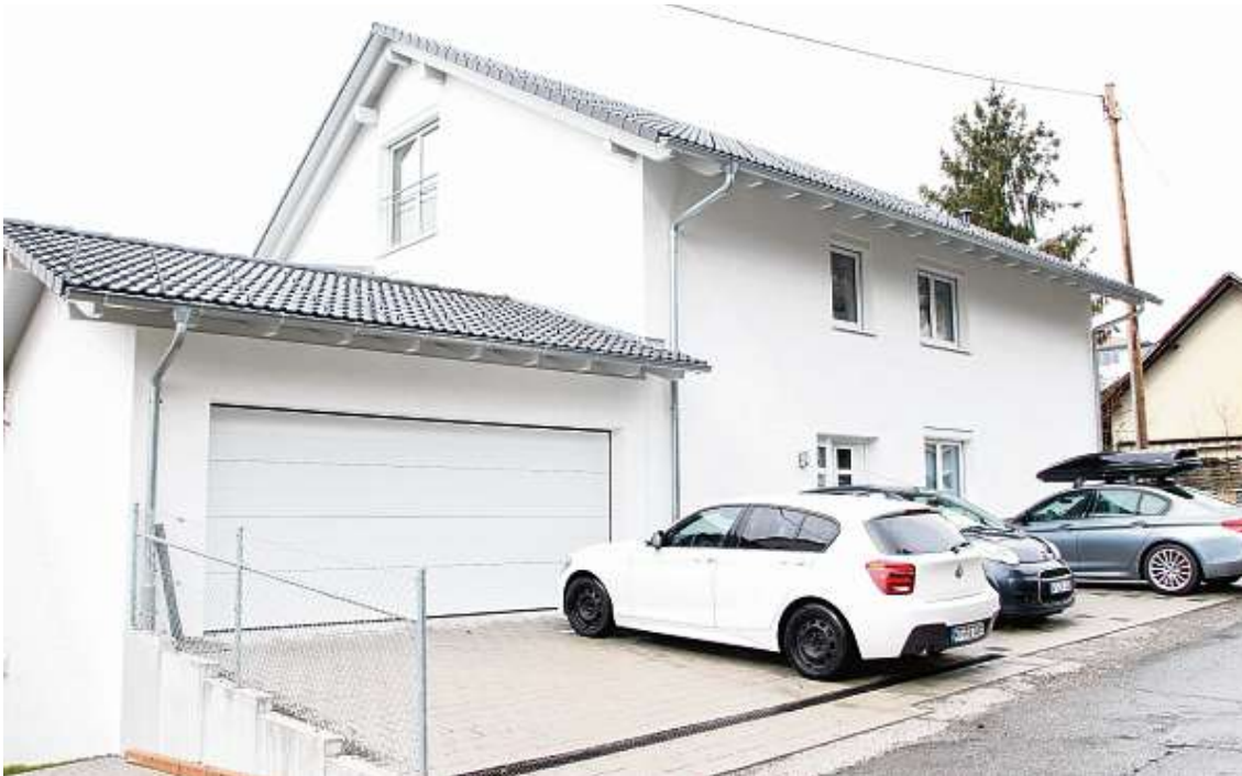
An das Haus angeschlossen ist eine Doppelgarage. Weil das Grundstück eine Hanglage ist, musste sie unterbaut werden. Darunter ist jetzt der Technikraum für die Heizung untergebracht.
