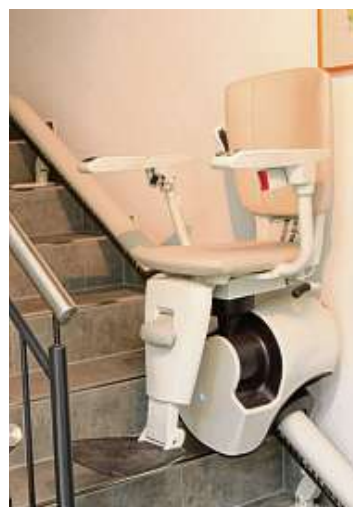
Obwohl noch nicht genutzt, hat sich der Hausherr einen Treppenlift im Treppenhaus einbauen lassen, damit er bequem in seine Wohnung ins Obergeschoss kommt.
