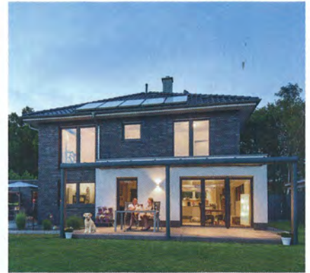
Graue Klinker, anthrazitfarbene Fensterrahmen und Dachziegel sowie weißer Putz verleihen dem Haus einen klaren Ausdruck.
