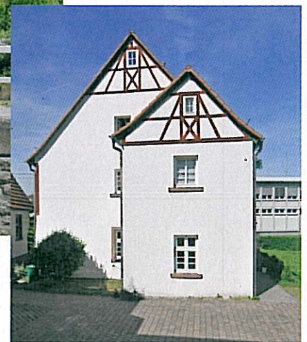
Vorder- und Rückansicht des historischen Fachwerkhouses nach der Sanierung.
