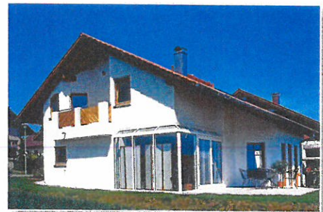
Der ohnehin kaum genutzte Loggiabalkon auf der Giebelseite wurde rückgebaut, komplett verglast und in das Kinderzimmer einbezogen.
