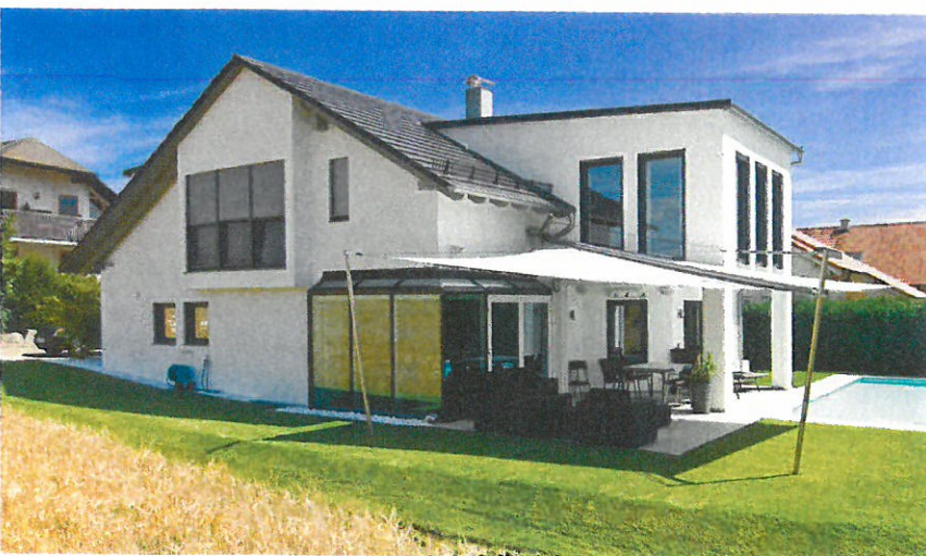
Der ohnehin kaum genutzte Loggiabalkon auf der Giebelseite wurde rückgebaut, komplett verglast und in das Kinderzimmer einbezogen.
