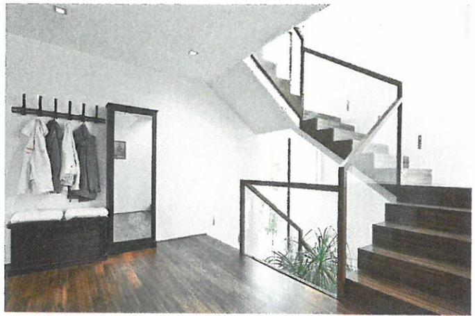
Die bequeme Stahlbeton-Podesttreppe mit Holzbelag und Glasgeländer liegt in einem Erker und wird effektiv durch zwei vertikale Glasbänder belichtet.
